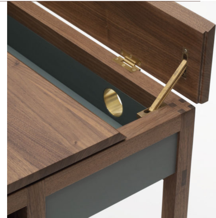
Dezenter Einsatz von Messing: Beschläge von Firma Eberhard, Kabeldurchlass von Firma Kirchner
