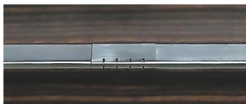
Kaum zu erkennen versteckt sich in der Edelstahllisene ein Scharnier
