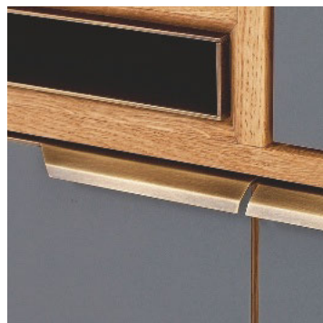
Die Metallkante des Einschubs verschattet die umlaufende Fasse
