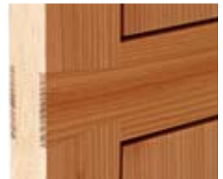
Die inneren Türfriese bilden oben einen parallelen Spalt und laufen unten zusammen. Die japanische Zinkung ist der Wendepunkt
